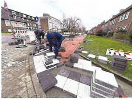
Die Bauarbeiter verlegen derzeit an der Herzogstraße die letzten Pflastersteine. Am Ende der Woche soll alles fertig sein. FOTO: JOCHEN KRÖHLER
